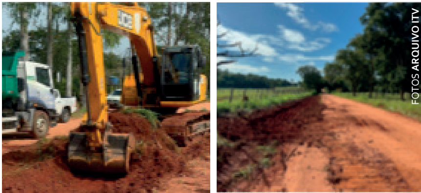
Obras executadas de readequação de estradas previstas no projeto PROSOLO Bonito.
